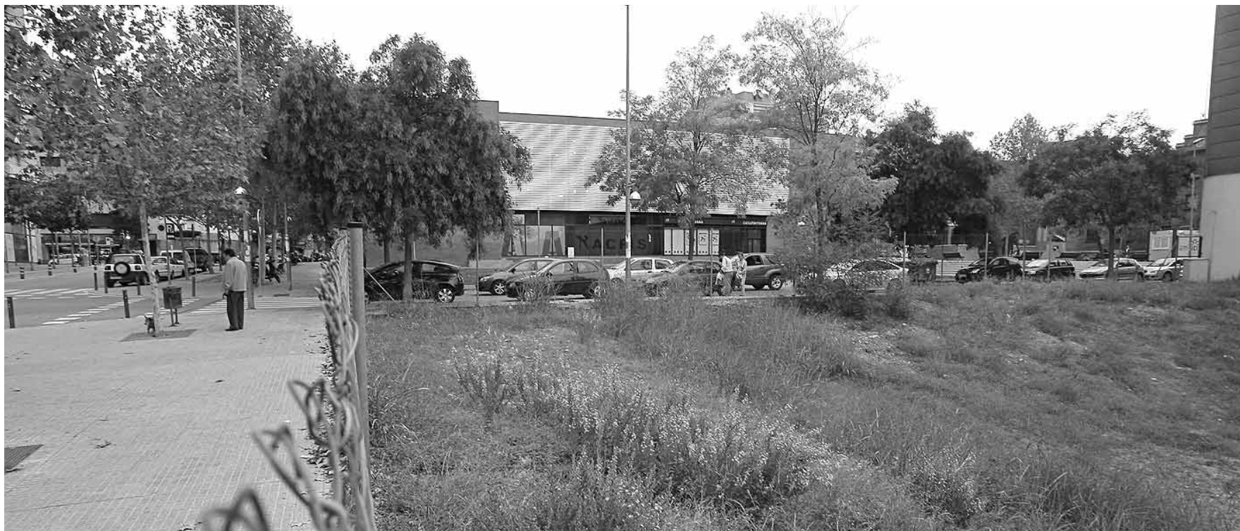
El solar cedido por el Ayuntamiento a la UPC para la construcción de viviendas está en la confluencia de la Rambla de Sant Nebridi con la calle de Miquel Vives.
